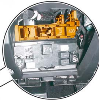
Relaisträger unter der Schalttafel links, über dem Steuergerät für Bordnetz
